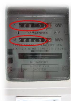
Μετρητής Γ1Ν (Ημερήσια και Νυχτερινή Μέτρηση)
