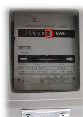
Μετρητής Γ1 (Ενιαία Μέτρηση)
